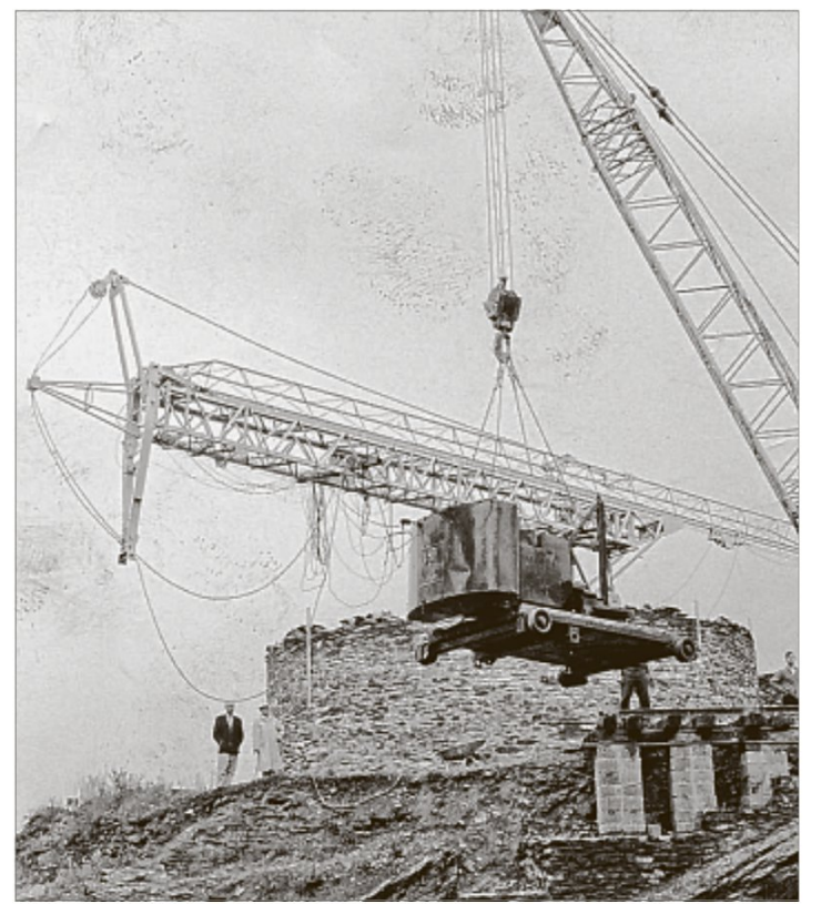
1967 – der Baukran wird geliefert: Mit seiner Hilfe wurde auf dem frei gegrabenen Stumpf der 16,5 Meter hohe Bergfried errichtet.
