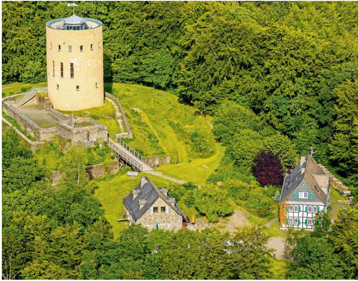
Zwischen Vorburg und Gewerkenhaus wird der Service-Pavillon errichtet. Von dort beginnt der barrierefreie Weg rund um den Burgwall zum Bergfried.
